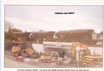
12/13 octobre 2002 - Un pont de 1600 tonnes glissé sous la voie ferrée.
